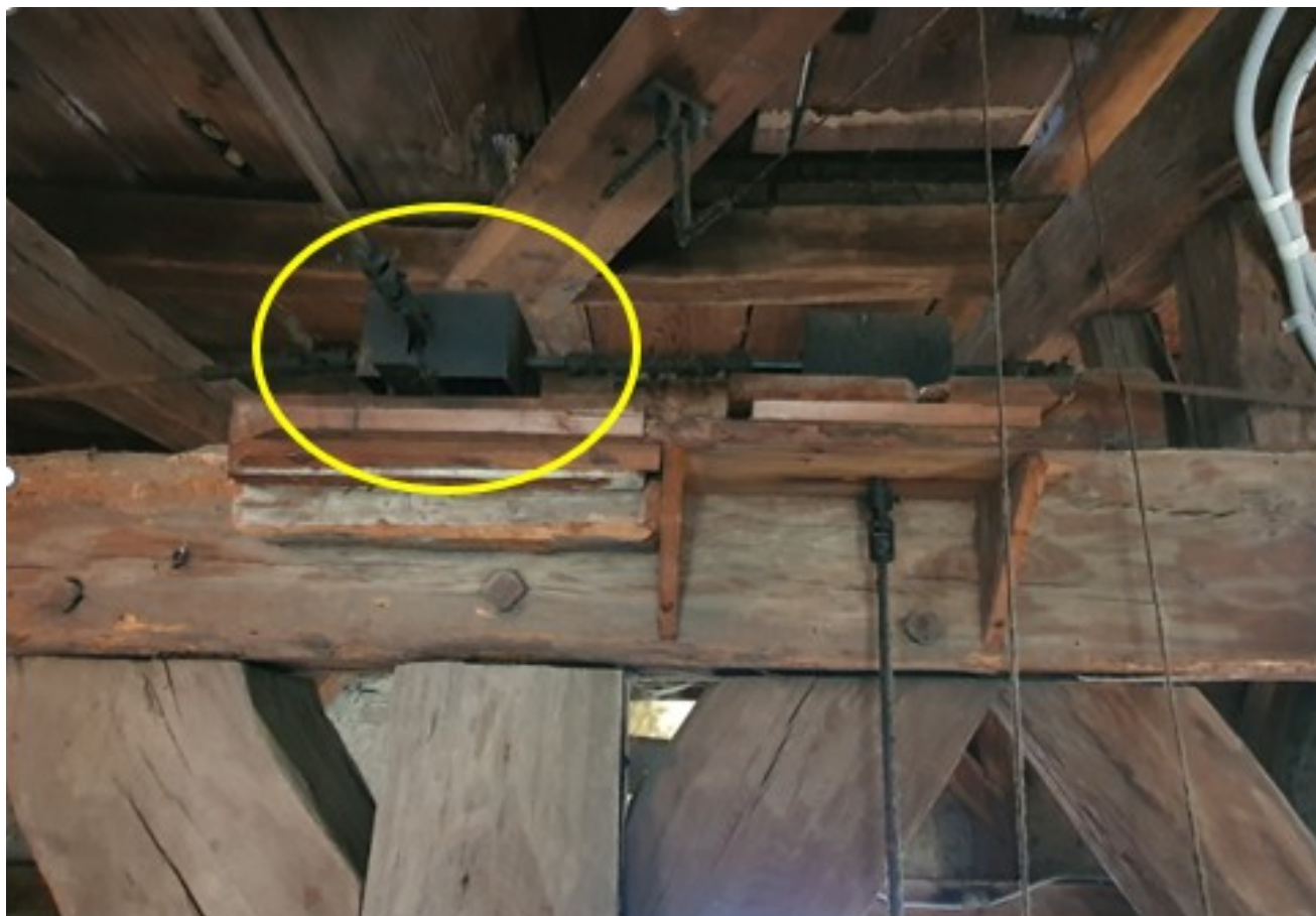
Detail umístění stávající převodové skříně
